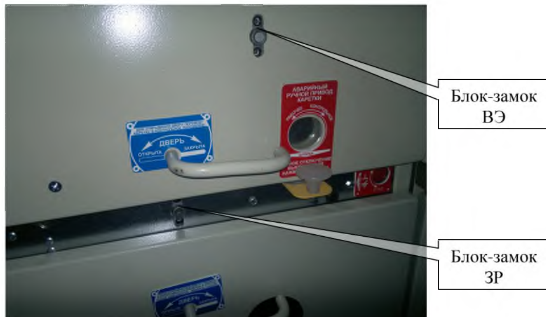
Рисунок 59 – Расположение электромагнитных блок-замков
