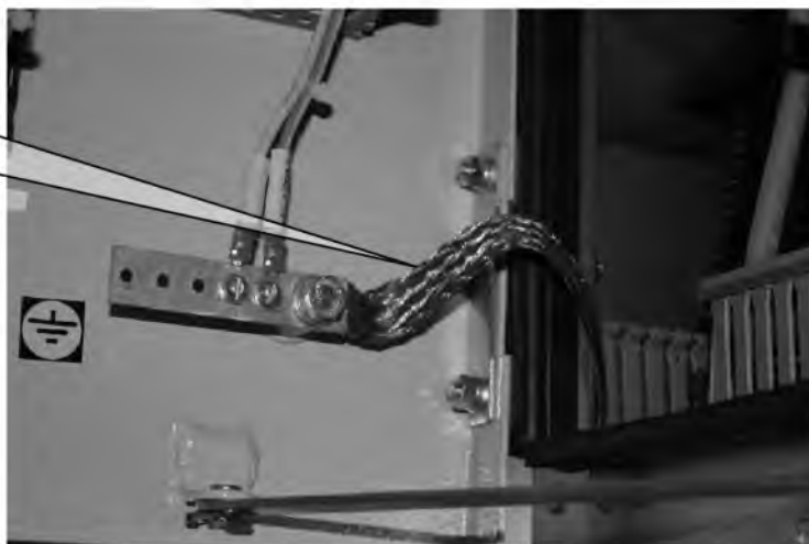
Рисунок 1- Заземление металлических частей шкафа.
