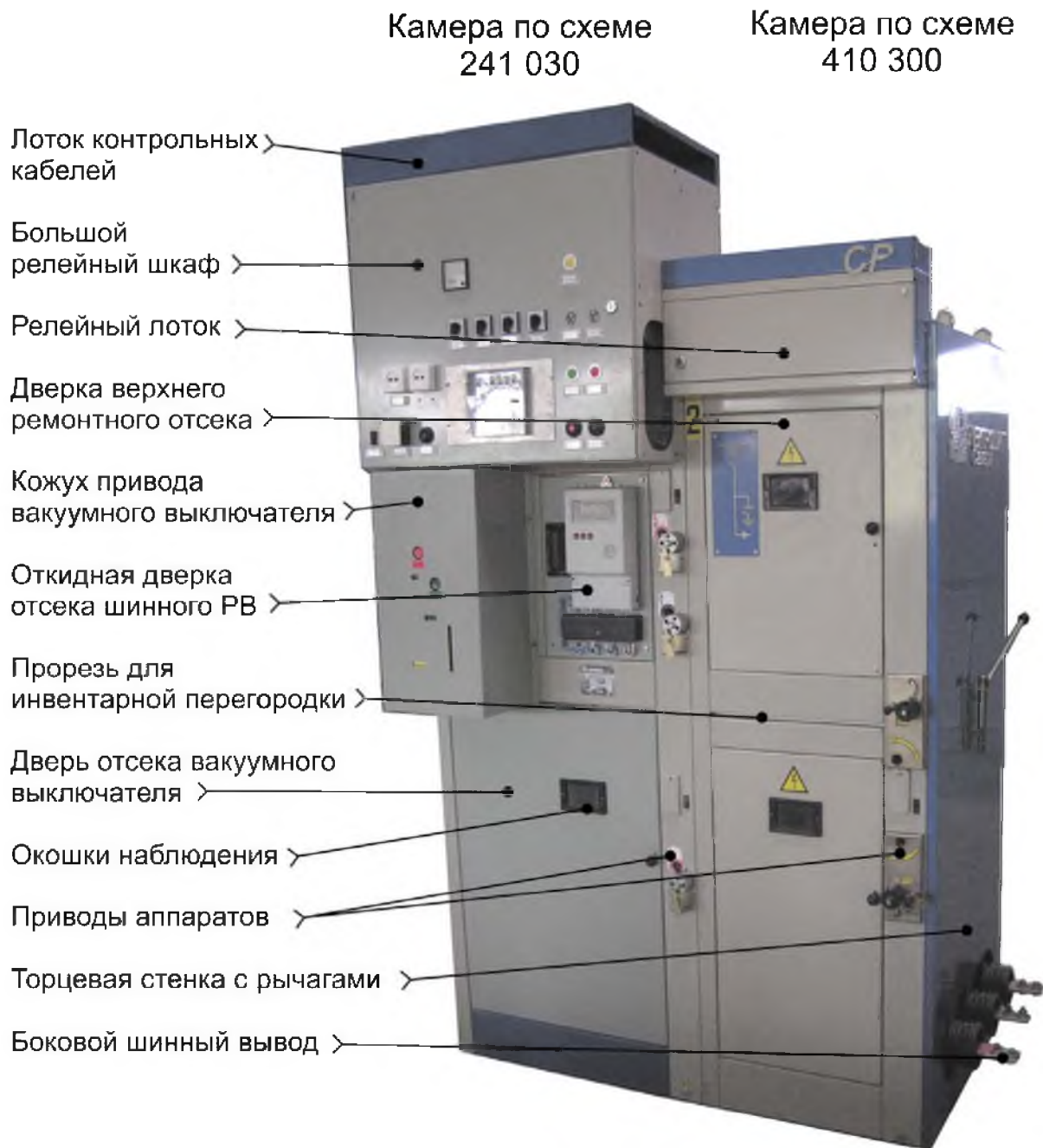
Рисунок 5 – Камеры с вакуумным выключателем и с разъединителем (условно поставлены рядом, с разными релейными шкафами)
