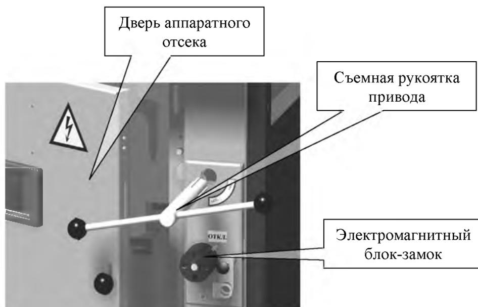
Рисунок 10а - Привод заземляющего разъединителя
