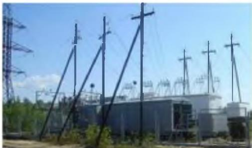
Проектом предусматривается замена физически изношенного, морального устаревшего оборудования ПС типа «СТ-7» польского производства на новое оборудование максимальной заводской готовности производства Электроцит Самара.
