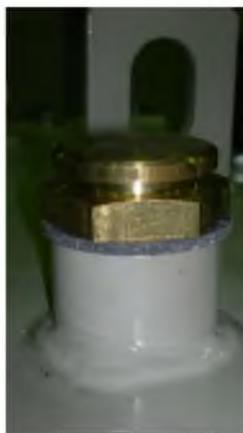
Рис. 7.5 Клапан сброса давления 25 VG
