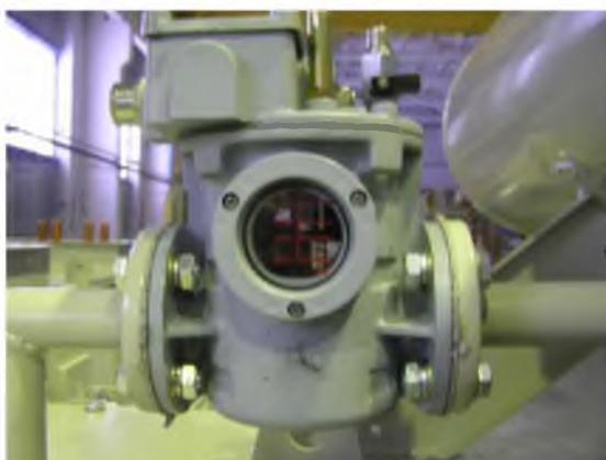
Рис. 7.8 Газовое реле **С01Н**
