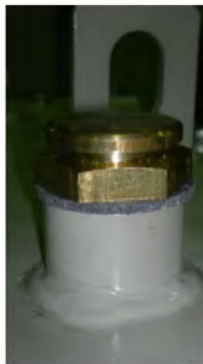
Рис. 7.6 Клапан сброса давления 25 VG
